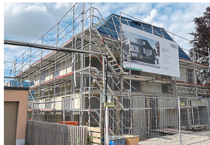
Der Rohbau für das „Effizienzhaus“ in der Ittisstraße (Waldtrudering) steht seit Juli 2022. Fünf Familien sollten hier einziehen.
